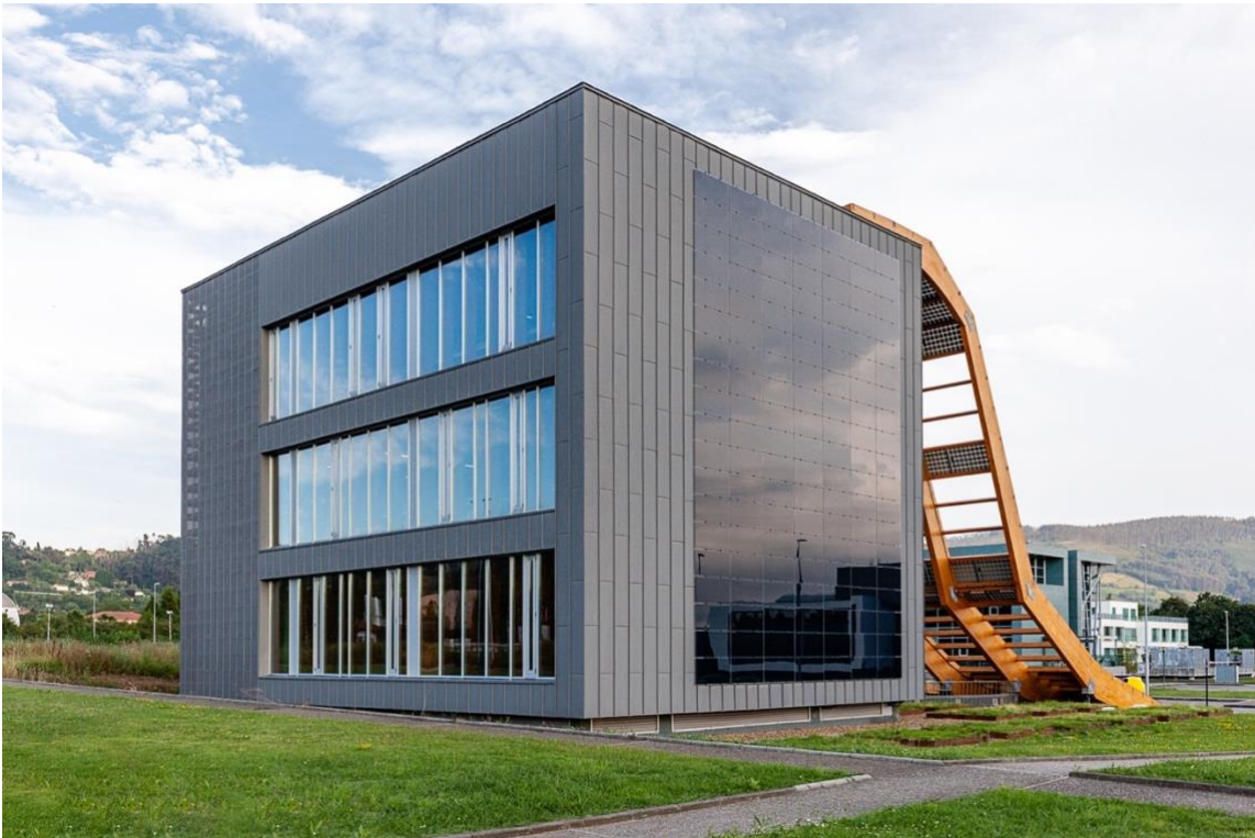
Figura 27. Fotografía fachada norte y oeste.
