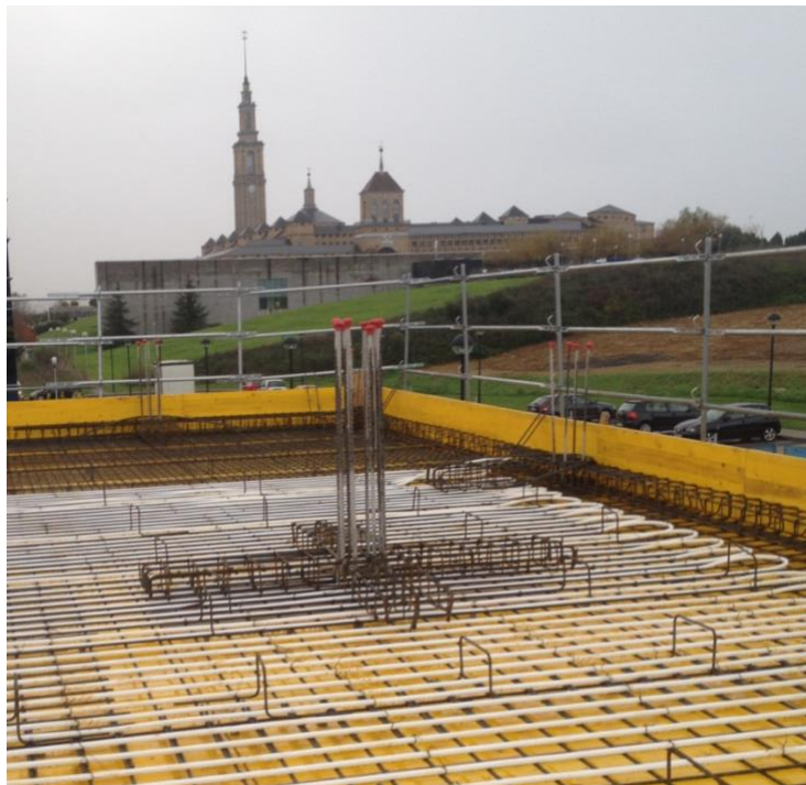
Figura 21. Fotografía ejecución losas de estructura termoactivadas .
