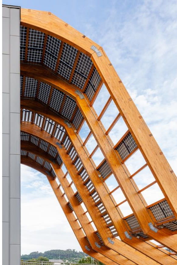
Figura 48. Fotografía Estructura de madera y paneles fotovoltaicos en fachada sur.
