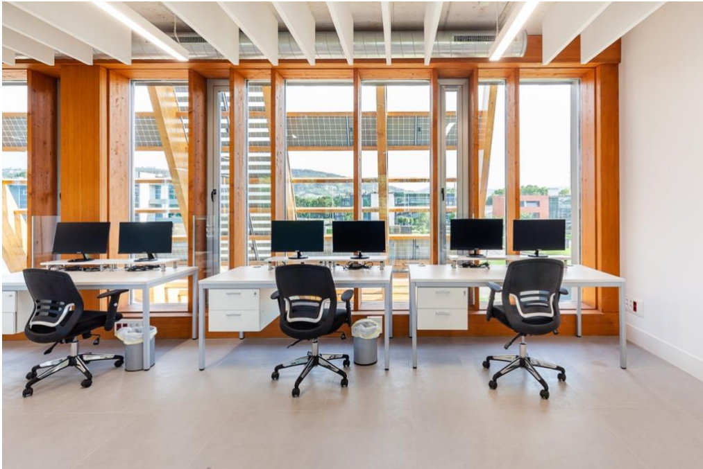
Figura 44. Fotografía interior fachada sur protección solar con panel fotovoltaico.
