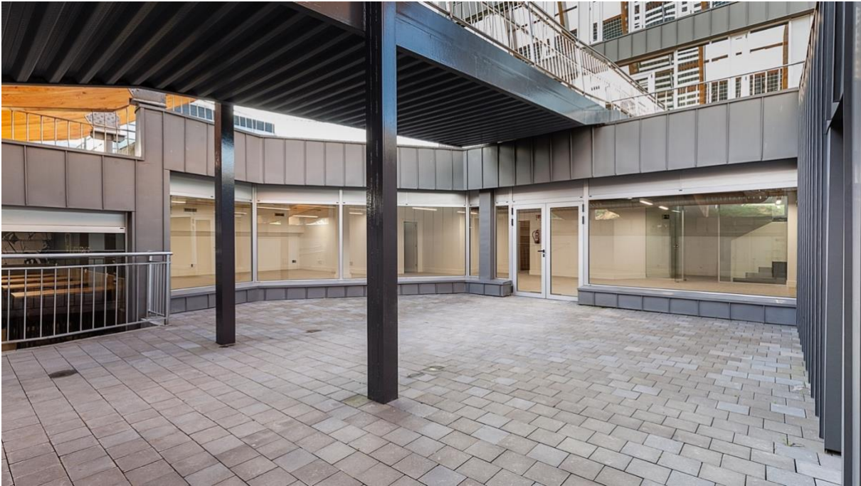
Figura 10. Fotografía Patio bajo Rasante.
