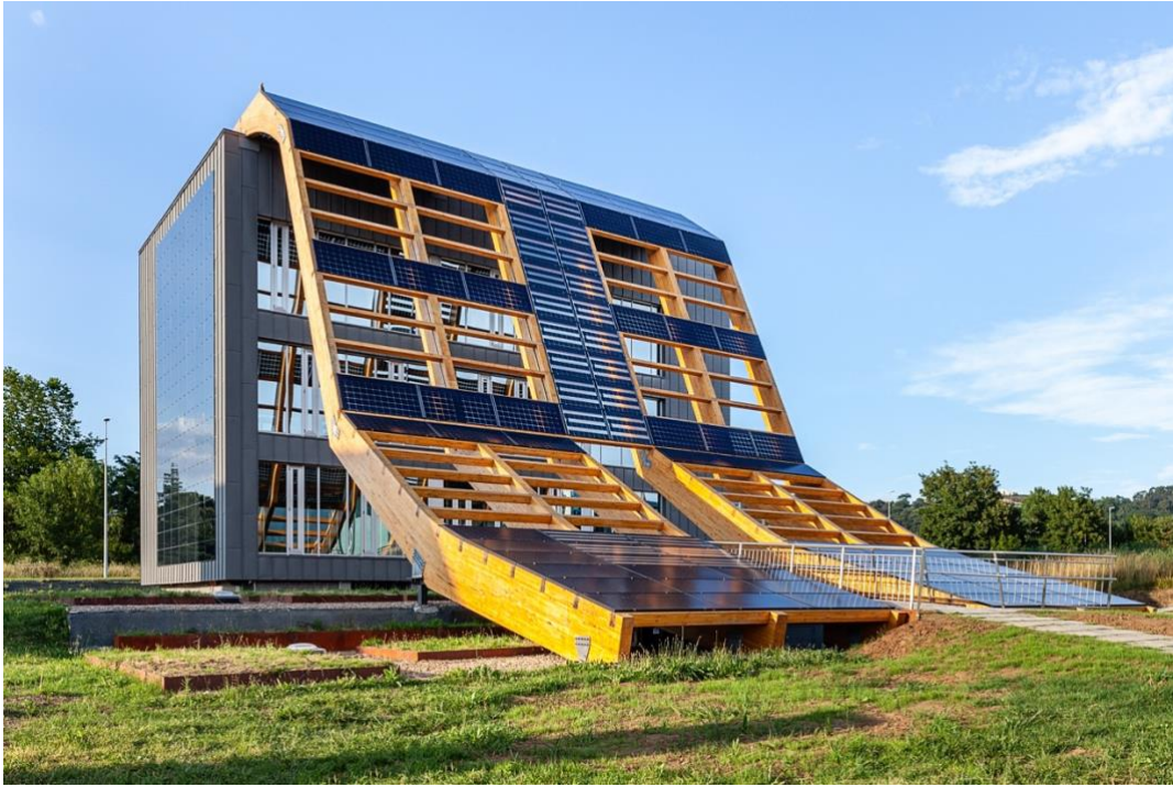
Figura 39. Fotografía fachada sur y oeste
