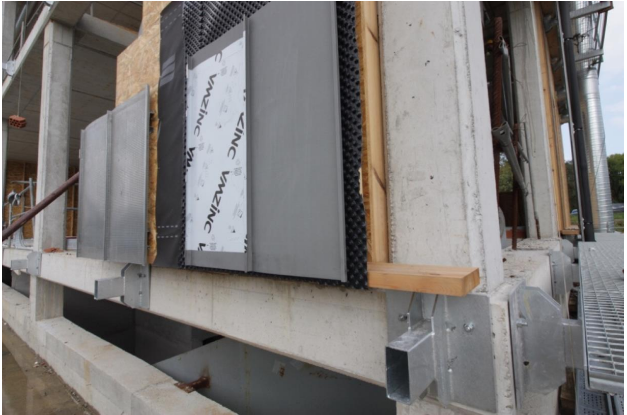
Figura 13. Fotografía ejecución de cerramiento de fachada.
