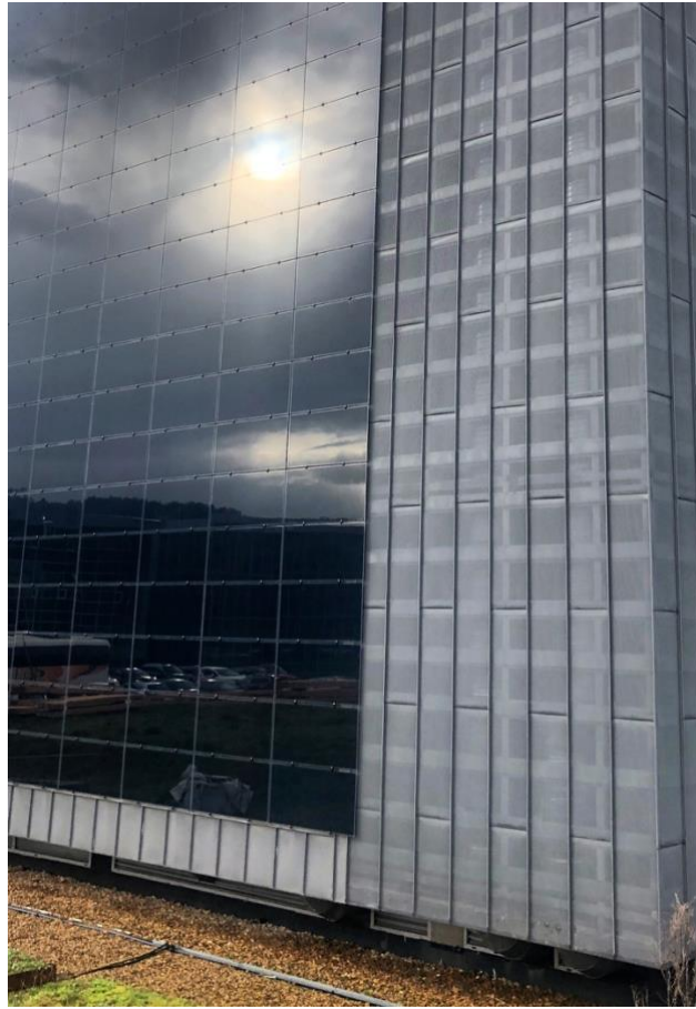
Figura 28. Fotografía detalle fachada este.
