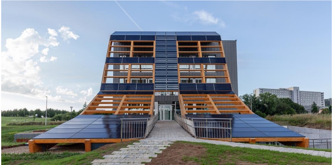
Figura 4. Fotografía alzado sur, acceso al edificio.
