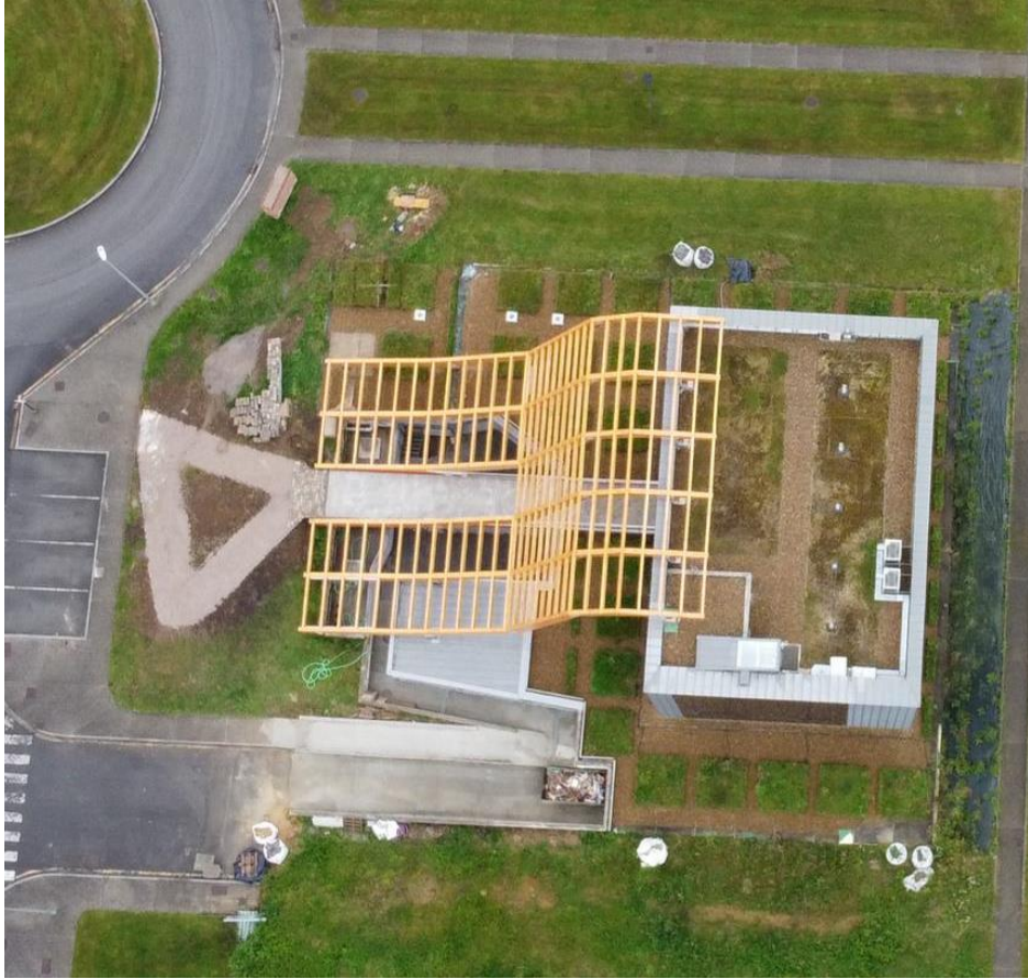
Figura 41. Fotografía aérea, ejecución de zonas ajardinadas reducción efecto isla de calor.
