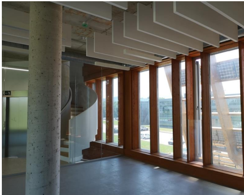
Figura 45. Fotografía interior fachada sur protección solar con panel fotovoltaico.
