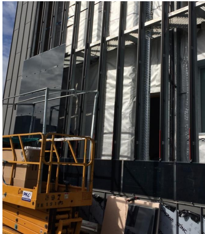
Figura 16. Fotografía instalación de paneles fotovoltaicos y cámara técnica con aislamiento exterior en el cerramiento de fachada.
