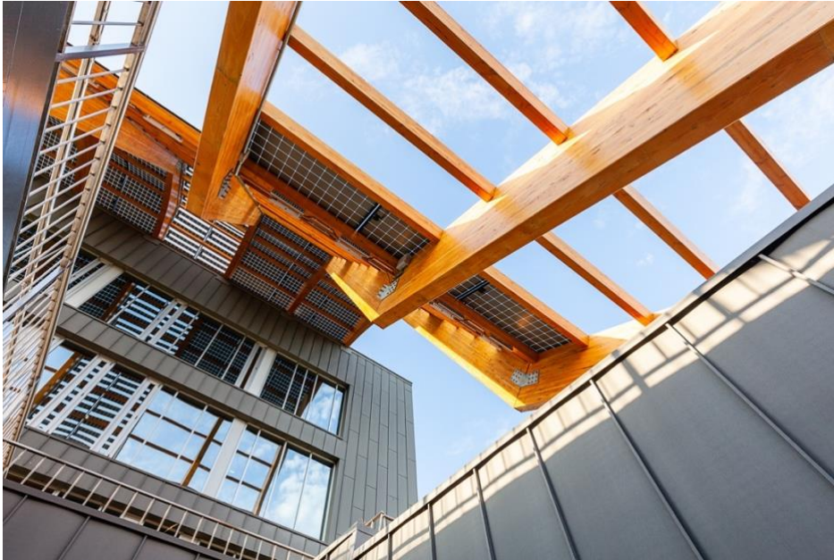
Figura 49. Fotografía vista desde patio de estructura de madera y paneles fotovoltaicos en fachada sur.
