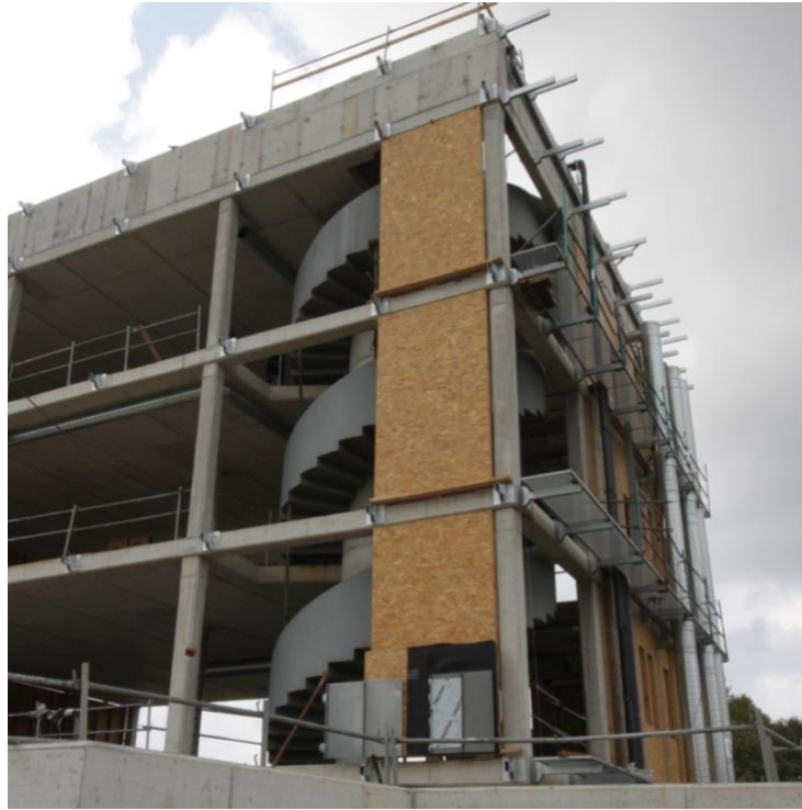
Figura 15. Fotografía de construcción de cerramiento de fachada.
