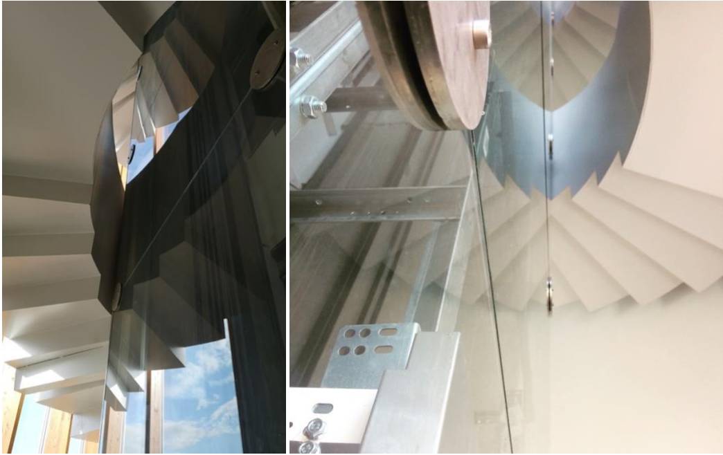
Figura 8 y 9. Fotografías Escalera y caja del ascensor.
