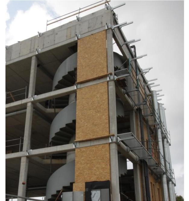
Ejecución de cerramiento cámara técnica con aislamiento exterior en el cerramiento de fachada.
