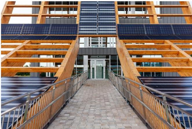
Fotografía paneles fotovoltaicos en fachada sur
