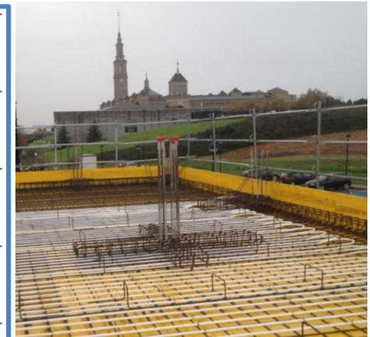
Ejecución losas de estructura termoactivadas
